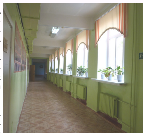
Коридор первого этажа
